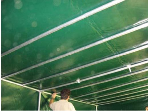
Jetzt die Dachstreben in Gefällrichtung einlegen und ausrichten. Falls später die Stangen durch Wind und Regen verrutschen, bitte die Klammern auf den Stangen mit dem Klebeband fixieren, damit sich keine Wassersäcke bilden können.
