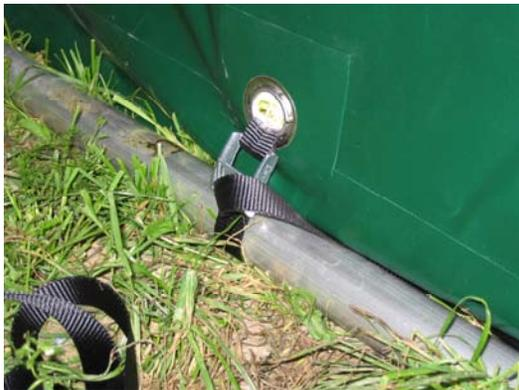
Die Planen werden nach unten mit den schwarzen Spanngurten unter der Stange hindurch gespannt.
