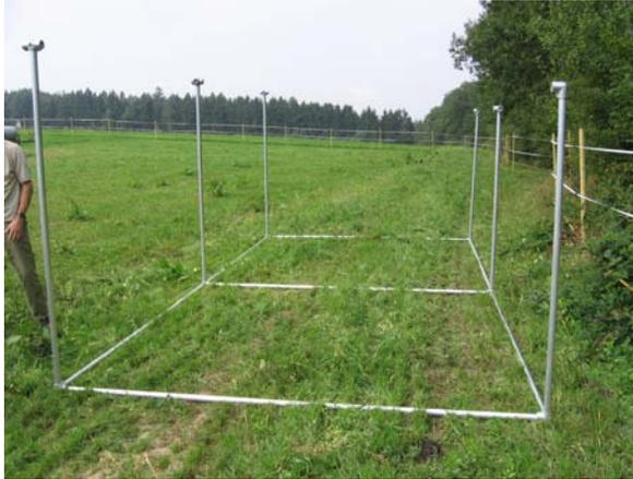
Bei allen Modellen legen sie die Bodenstangen entsprechend den Maßen ihres Weidezelttes am Boden aus und montieren die senkrechten Stangen an den passenden Stellen: vorne die höheren und hinten die niedrigeren. Zur Hilfe ist der untere Verschluss mit grüner Farbe markiert. Die Rohre bis zum Anschlag in die Verschlüsse stecken und die Schrauben mit der Ratsche anziehen
